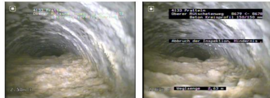
Abbildung 3: Haltung 8678, ZK 0, starke Ablagerungen
